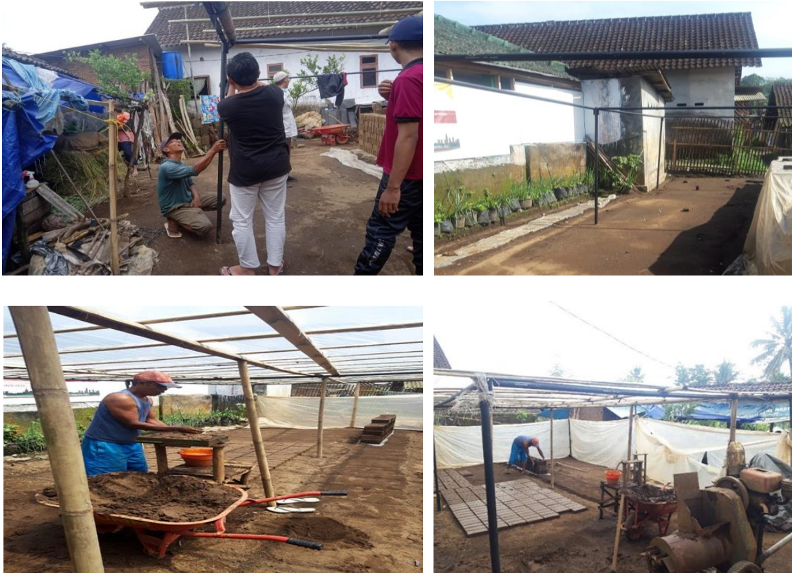
Gambar 5. Pemasangan Rangka Barak Kerja Industri Rumahan
